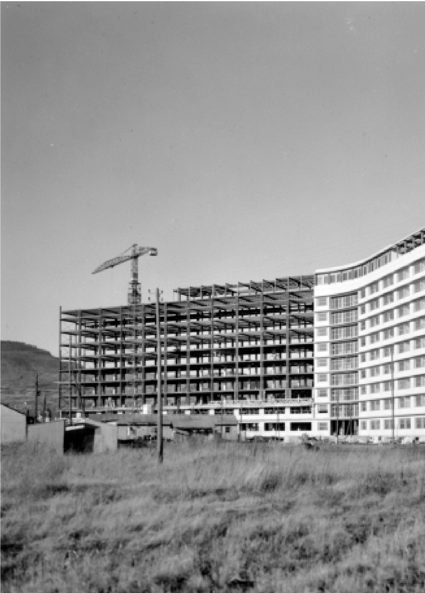
Construction de Gabriel-Montpied en mai 1964
